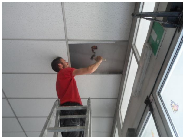
La fase diagnostica, con apertura di tasselli di indagine
